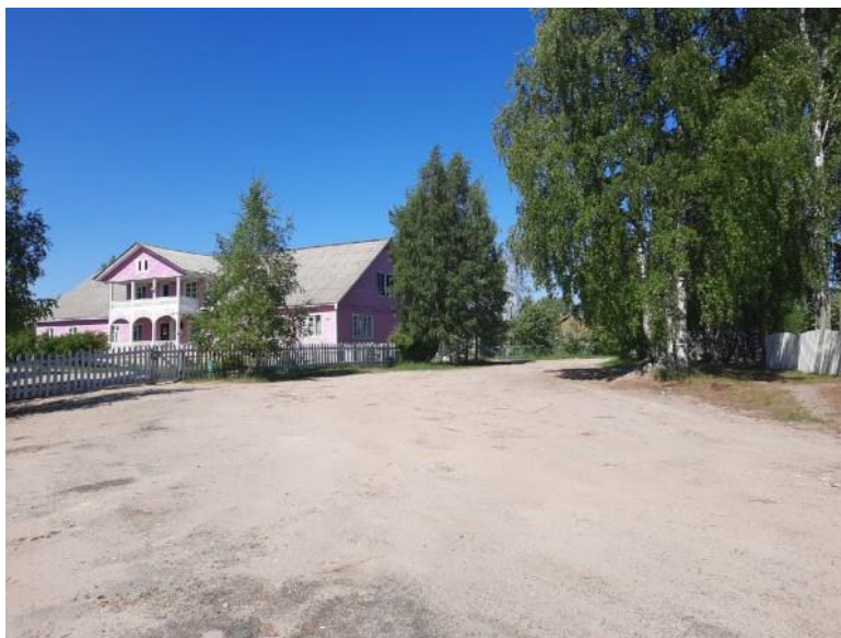
Рисунок 2. Отсутствие тротуаров в поселке Калевала.
