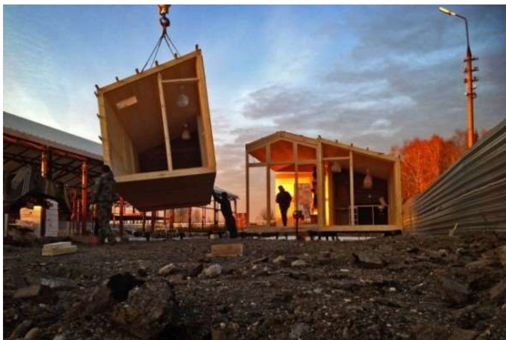
Рисунок 1. Сборка каркасно-модульного блока [4]
