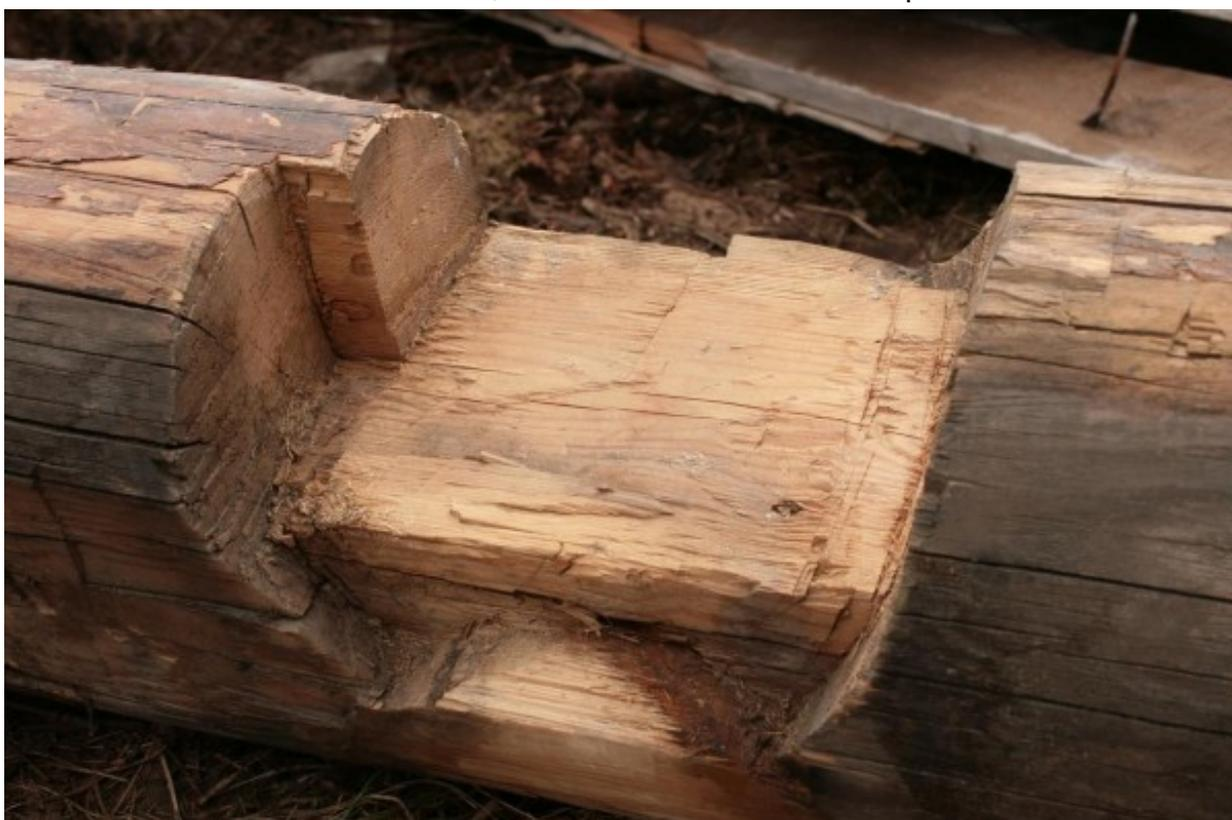
Рис. 6. Чаша в бревне, выполненная топором.
