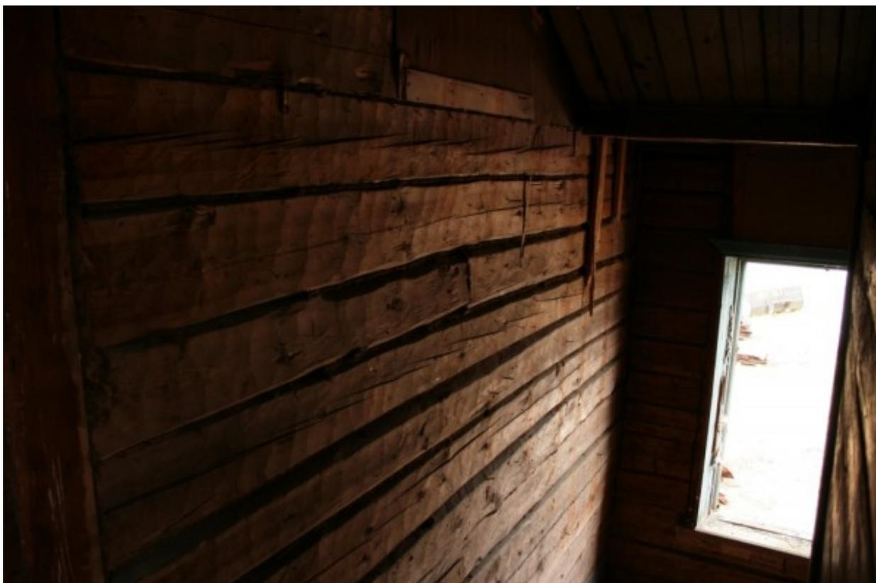
Рис. 5. Участок стены больницы, сложенной из тесанных бревен.
