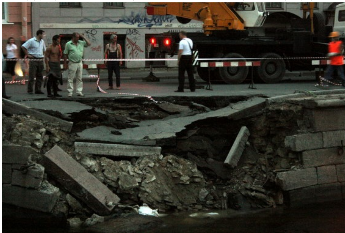
Рис. 5. Обрушение стенки канала Грибоедова. 2010.
